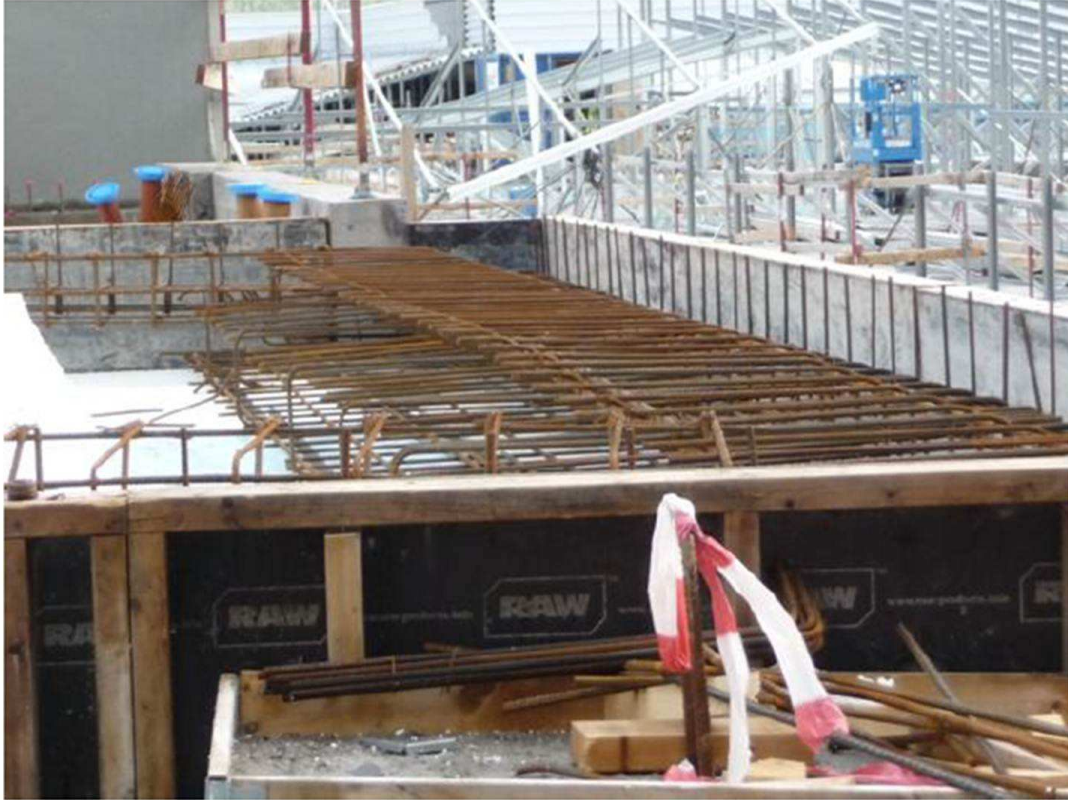
Figur 30: Armering av bottenplatta, Rågården
